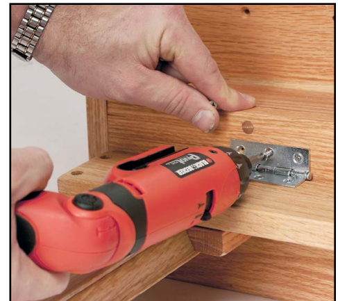
1b. Remove bottom hinges
